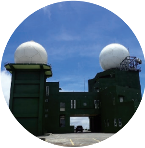
五分山 S 波段（右）及 C 波段降雨雷達維修平台（左）
