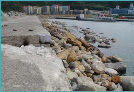
2002年辛樂克颱風過後，堤防破壞情形。
