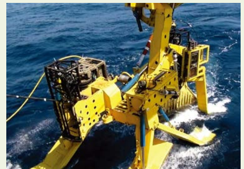
◎海纜鋪設作業－犁埋機入水
