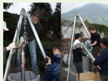
儀器安裝及測試
