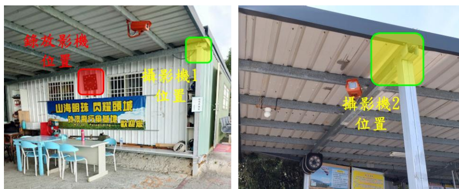
圖 2-16 宜蘭縣外澳裂流監測站錄放影機和攝影機更新位置示意圖
