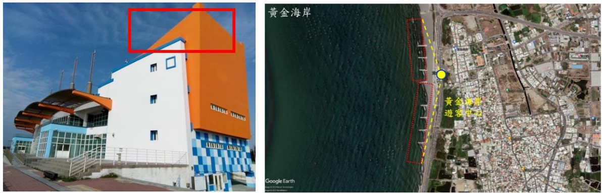
圖 2-10 臺南市黃金海岸監測站建議架設位置與觀測區域(左.建置位置、右.拍攝範圍)
