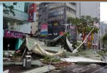
招牌毀損掉落傷及行人
